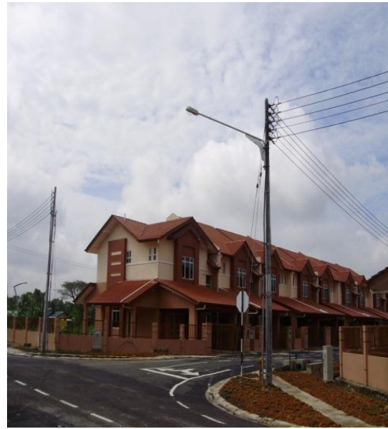
Kabel atas dipasang selari dengan jalan dikawasan kediaman
